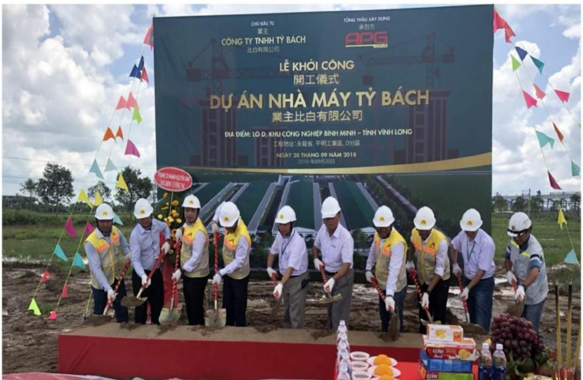
Khởi công dự án Nhà máy Tỷ Bách tại khu công nghiệp Bình Minh
