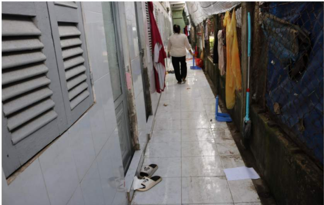
Hành lang một khu gát trọ công nhân (hẹp, bẩn, không đảm bảo an toàn phòng cháy, chữa cháy...)
