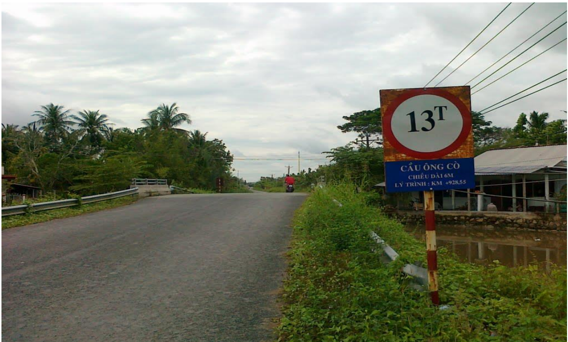
Hình 2.8. cầu Ông Cò bắt ngang kinh Ông Cò (quận Cái Răng) Nguồn: tác giả, năm 2020
